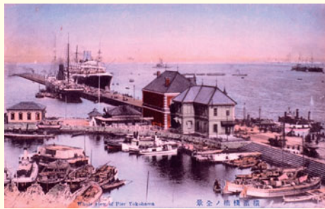
1900～1910年(明治33～43年)頃 横浜港第一期築港工事で完成した鉄棧橋(現大さん橋) (横浜マリタイムミュージアム所蔵)
